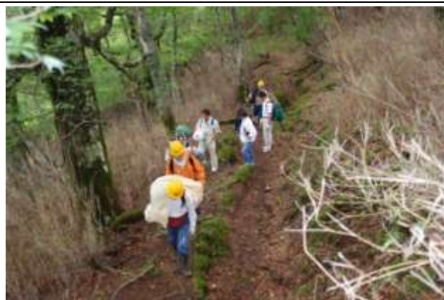
補修資材の運搬 09.06.11
