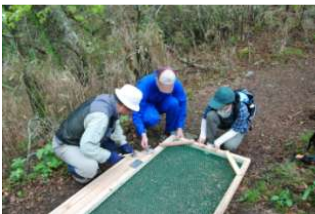
ネット補修&扉取付 090517
